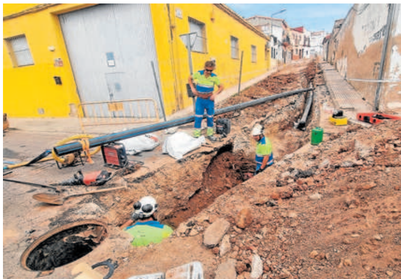
Obras actualmente en marcha en la barriada de San Juan. J. M. ROMERO
